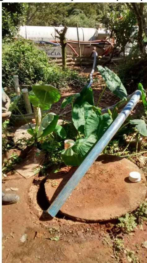
Figura 18 - Manutenção do Tanque Séptico
