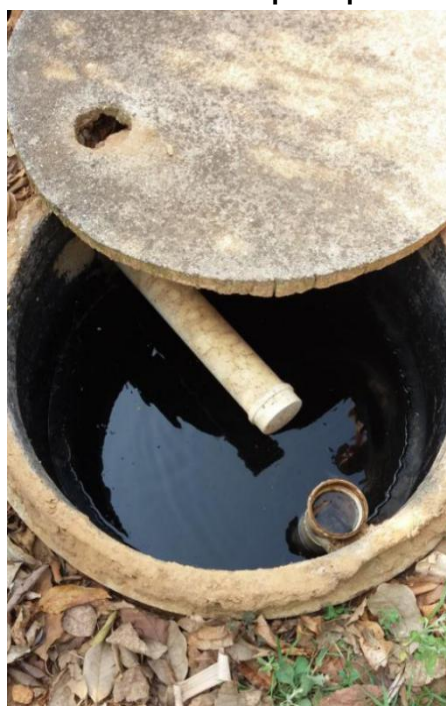
Figura 13 – Sistema de tanque séptico entupido.
