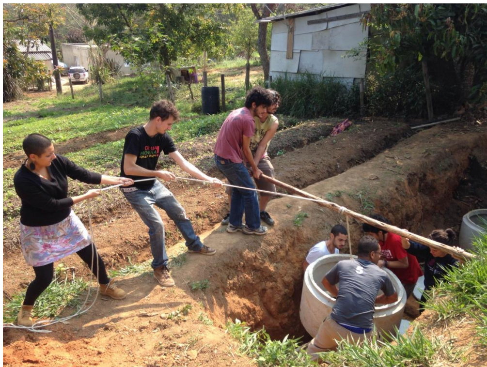
Figura 18 - Manutenção do Tanque Séptico
